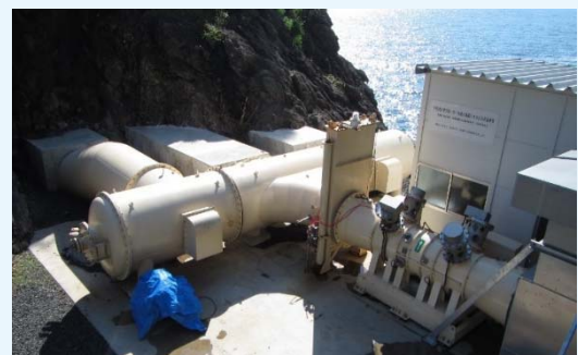
発電中のブローホール波力発電装置 (福井県越前町)
